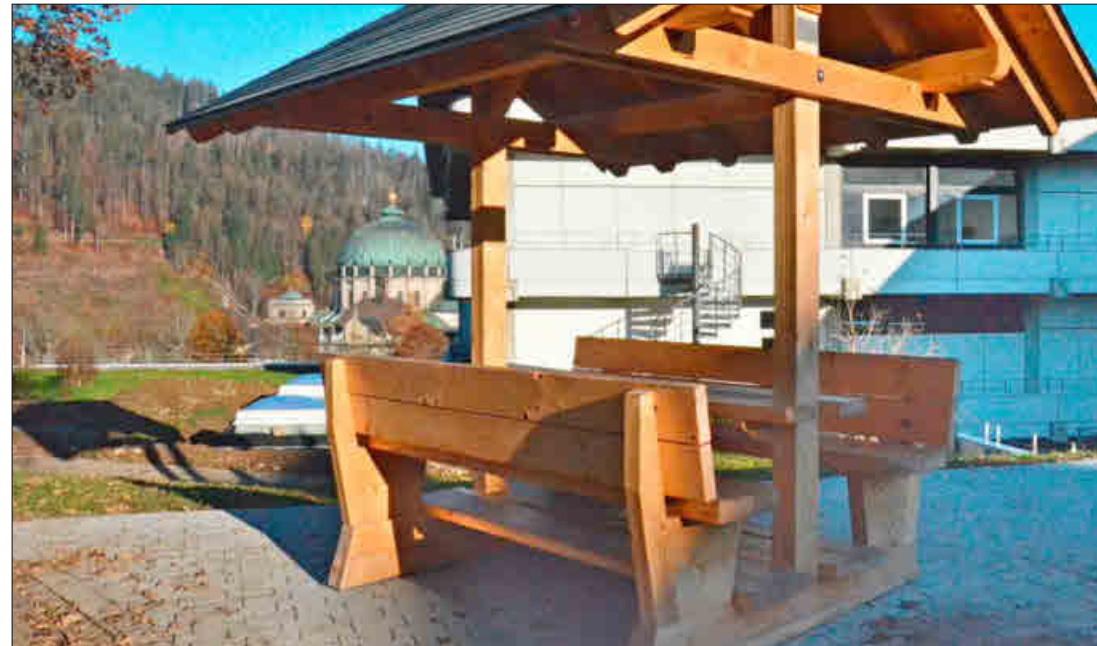
Sichtbarer Erfolg: Einen überdachten Sitzplatz hatten Schüler im Rahmen eines Projektes gebaut.
